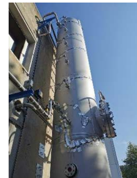
Boucle –Bassin représentatif mur d'Eau
