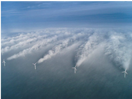
Figure: Horns rev offshore wind farm, Vattenfall, 2008
